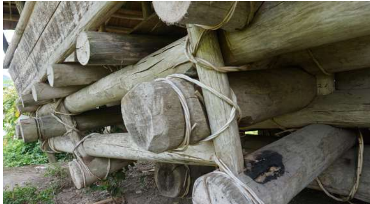
Gambar 29. Pondasi kayu rumah adat Lobo yang tahan gempa
