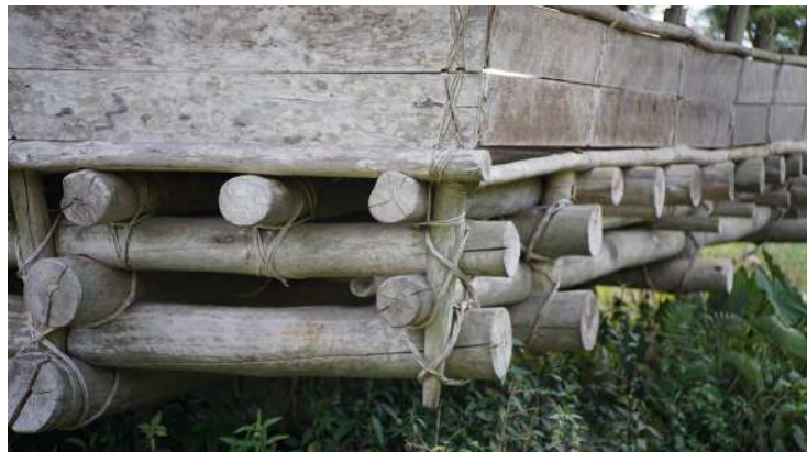
Gambar 30. Paku tidak digunakan pada rumah adat Lobo
